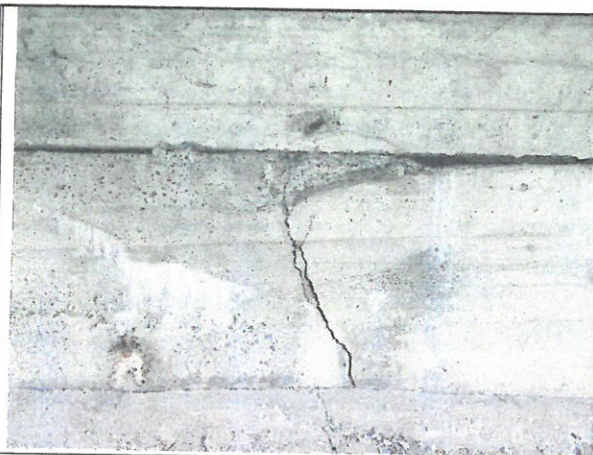
Fot. 16. Pęknięcie pionowe przeciążeniowe od naporu nasypu oraz uszkodzenia powierzchniowe i strukturalne, powierzchniowe podwaliny podporowej Nr 2, przecieki od strony zasypki
