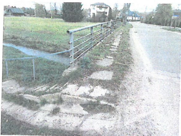
Fot. 11 Widok lewego chodnika z zejściem na schody, zarośnięta nawierzchnia chodnika, deformacje płyt betonowych
