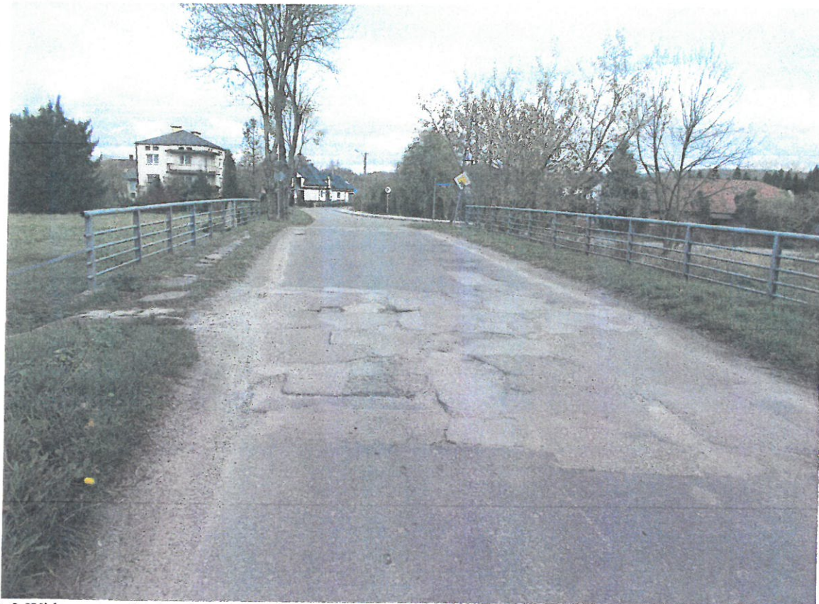
Fot. 3 Widoczne uszkodzenia powierzchniowe i strukturalne nawierzchni dojazdu, zarośnięte chodniki
