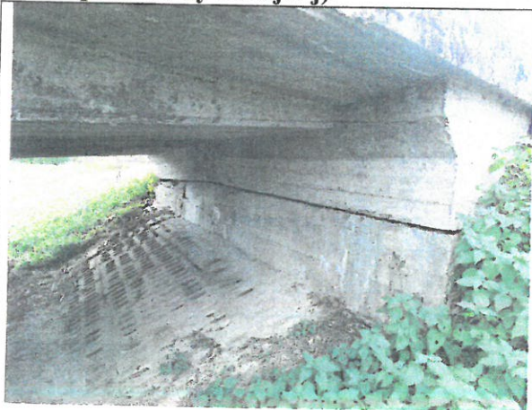
Fot. 9 Widok strefy podparcia na podporze skrajnej Nr 2, ubytek nasypu, pęknięcia podwaliny
