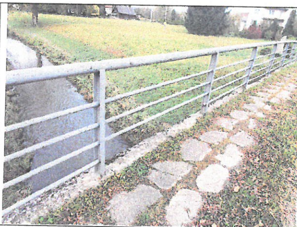
Fot. 18. Ubytek w prześle balustrady str. lewa
