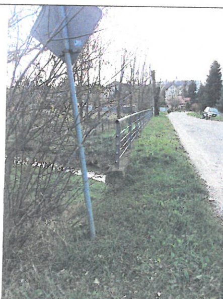
Fot. 20. Zakrzaczenie skarpy na dojeździe, odchylony znak pionowy
