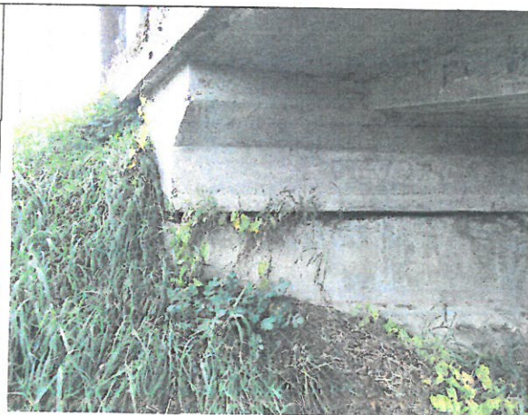
Fot. 10 Widok strefy podparcia na podporze skrajnej Nr 1, ubytek nasypu, roślinność w szczelinie połączeniowej podwaliny i wspornika pomostu
