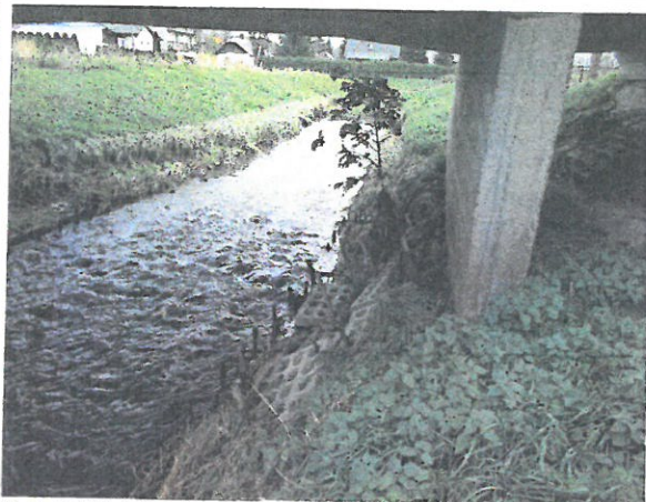
Fot. 6 Widok tylnej części podpory Nr 1, uszkodzenie umocnienia brzegowego
