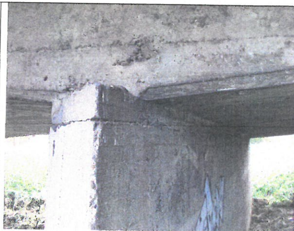
Fot. 8 Widok strefy podparcia na podporze środkowej Nr 2, ubytek w rejonie przegubu na filarze
