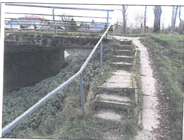
Fot. 17. Schody skarpowe i pochylnia, deformacje spoczników i obrzeży
